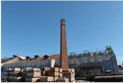
図1 旧ヒダ工場（改修中）
