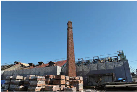
図1 旧ヒダ工場（改修中）
